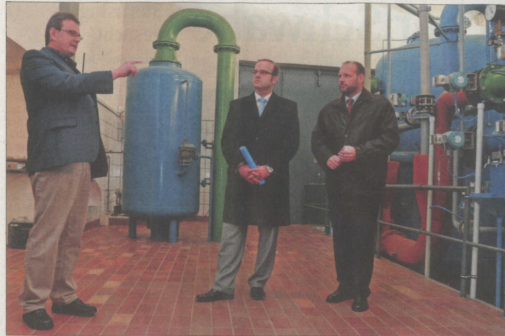
Badenova-Projektleiter René Knauf (links) erläutert die neue Steuerungstechnik im Wasserwerk Ried. Die Bürgermeister Alexander Schröder (Meißenheim, Mitte) und Wolfgang Brucker (Schwanau) lauschen ihm interessiert. Fotos: Möller-Schaller
